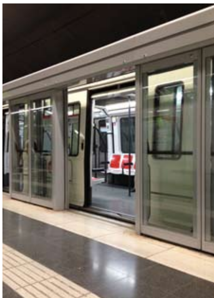
Inglasad vägg på perrongen där dörren öppnas när tåget kommer och stängs när tåget går.
